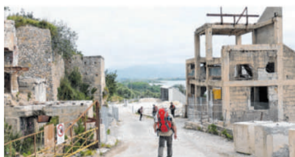
Reste des Baubooms: Vielerorts haben Häuser- und Straßenbau die Spuren der alten Straße verschluckt.
